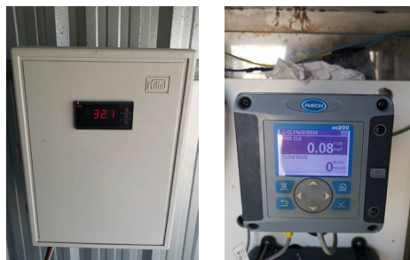
ภาพที่ 2-23 เครื่องตรวจวัดอุณหภูมิ และคลอรีนอัตโนมัติ
