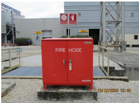
Fire Hydrant และตู้เก็บอุปกรณ์ดับเพลิงมือถือ
