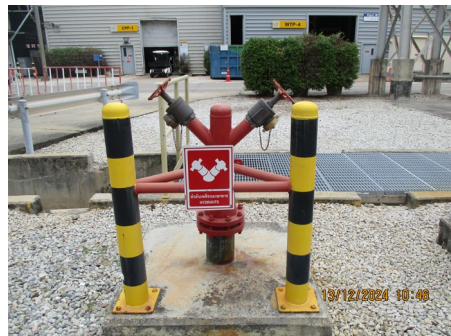
Fire Hydrant และตู้เก็บอุปกรณ์ดับเพลิงมือถือ
