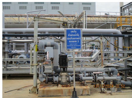
ภาพที่ 2-16 ระบบปรับสภาพน้ำให้เป็นกลาง
