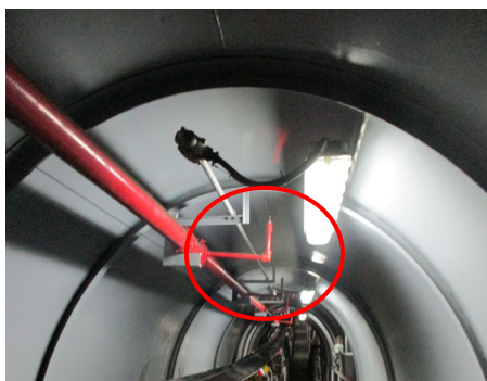
ภาพที่ 2-46 อุปกรณ์ป้องกันอัคคีภัยบริเวณสายพานลำเลียงถ่านหิน
