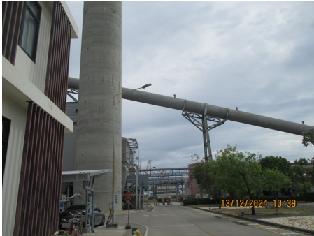
ภาพที่ 2-1 แนวสายพานลำเลียง ถ่านหินแบบปิด
