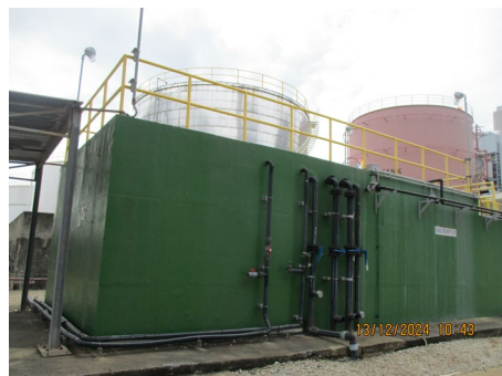
ภาพที่ 2-20 ระบบบำบัดน้ำเสียทางชีวภาพ
