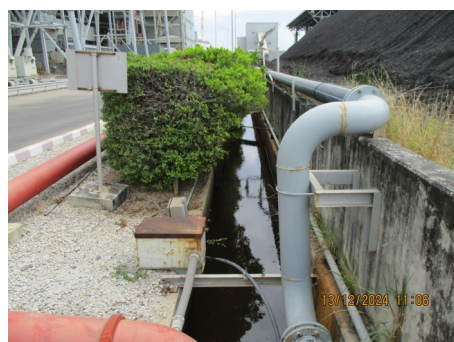
ภาพที่ 2-18 รางรวบรวมน้ำรอบลานกองถ่านหิน
