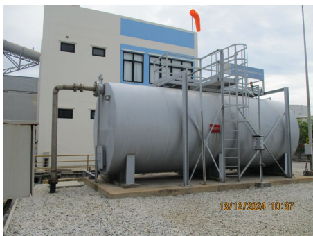
ภาพที่ 2-22 ระบบแยกน้ำ-น้ำมัน
