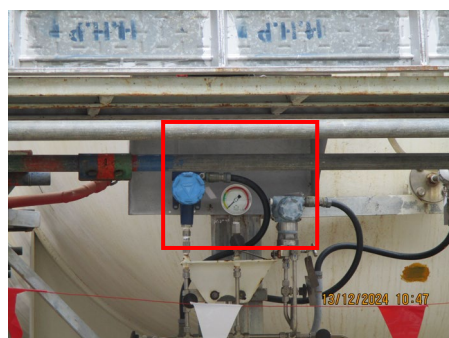
ภาพที่ 2-44 อุปกรณ์ตรวจวัดความดันของถังเก็บพักและระบบท่อลำเลียงแอมโมเนียแอนไฮไดรส์
