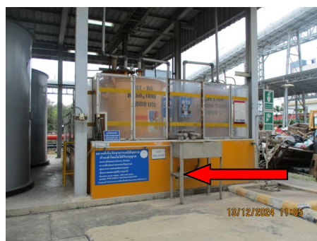
ภาพที่ 2-41 คันคอนกรีตรอบถังพักสารเคมี
