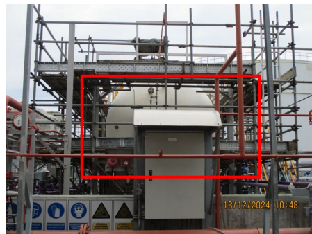
ภาพที่ 2-43 ระบบฉีดพ่นม่านน้ำบริเวณถังเก็บพัก แอมโมเนียแอนไฮไดรส์
