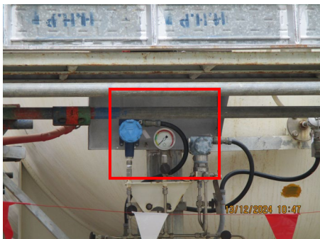
ภาพที่ 2-42 ระบบ Gas Detector บริเวณถังเก็บพัก แอมโมเนียแอนไฮไดรส์
