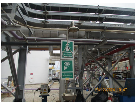
ภาพที่ 2-40 อ่างล้างตาและร่างกายฉุกเฉิน
