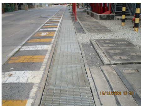
ภาพที่ 2-21 ระบบระบายน้ำฝนภายในโครงการ
