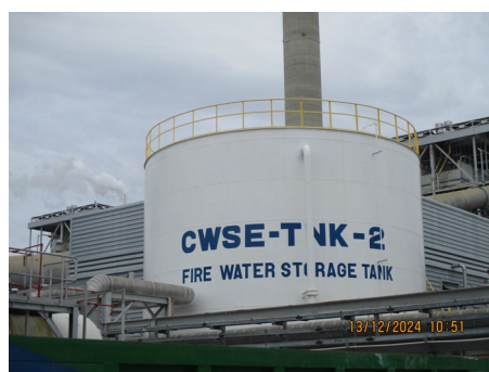
ถังเก็บน้ำสำรองสำหรับดับเพลิง
